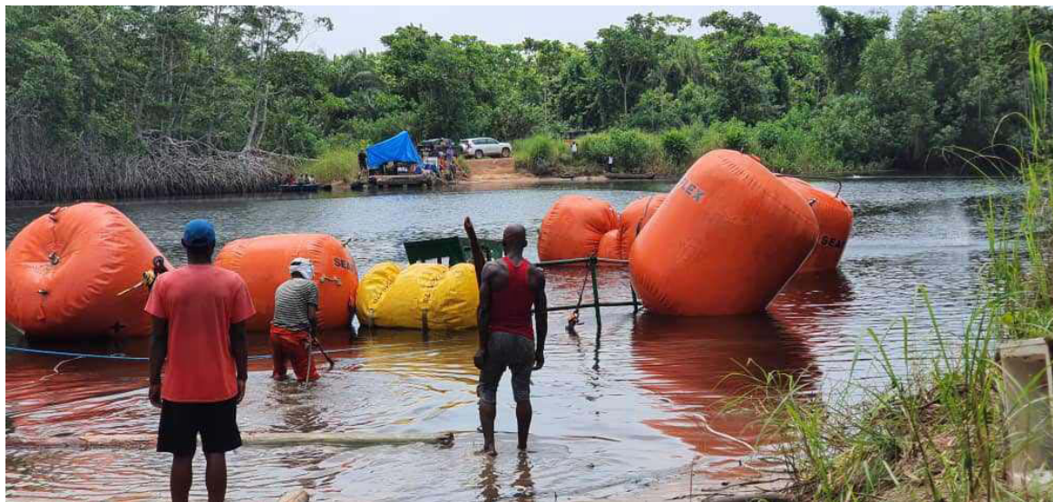
L'opération d'extirpation du véhicule immergé dans la Noubi/DR
