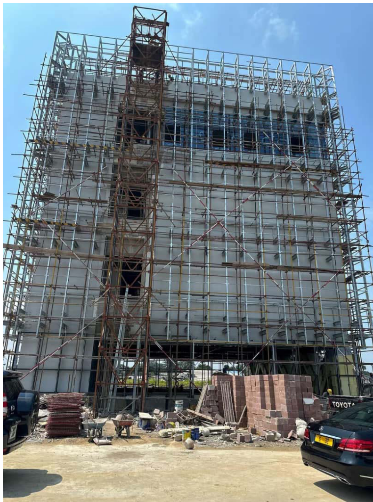
Le siège du Datacenter national en construction / Adiac
