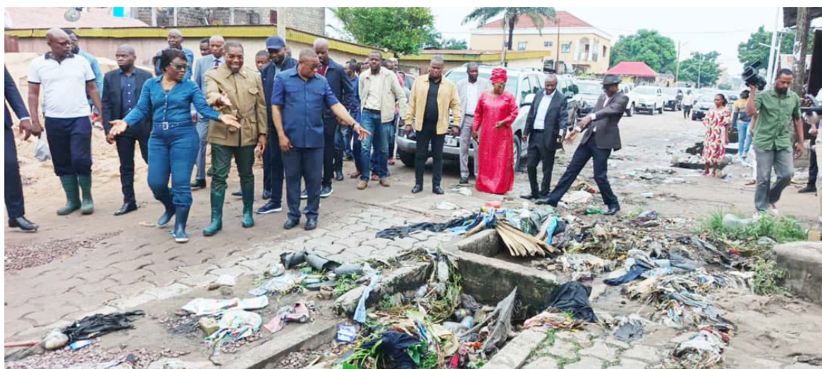
Une canalisation bouchée à Ouenzé DR
