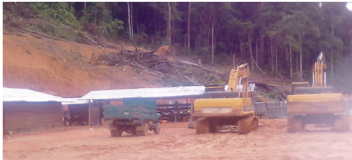
Des engins exploitant sur le site de Dionika/Adiac
