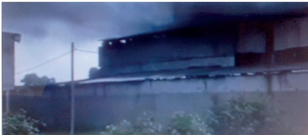
Des gaz toxiques dégagés par la société Metssa-Congo avant sa délocalisation/Adiac
