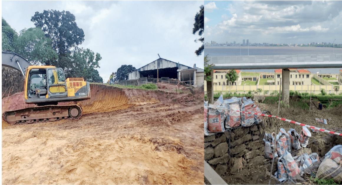
Le chantier a déjà transformé radicalement le visage du site
