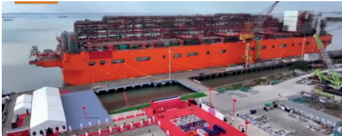
L'usine flottante «Nguya Flng» DR
