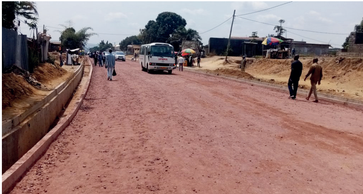
Un tronçon de l'avenue Blaise Adoua au quartier domaine en chantier/Adiac
