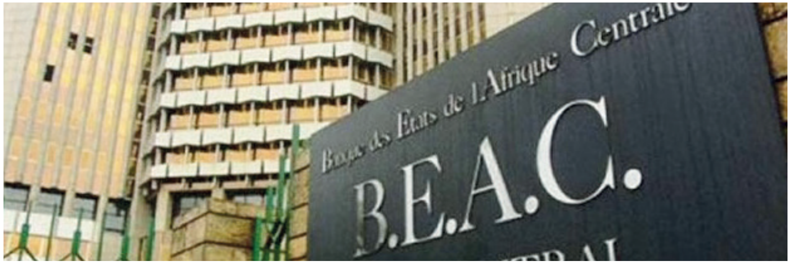
Le siège de la Banque centrale à Yaoundé, au Cameroun/DR
