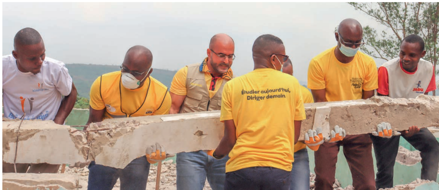
DG de MTN Ayham Moussa accompagne des Mtners et partenaire durant la démolition du bâtiment à Makana2
