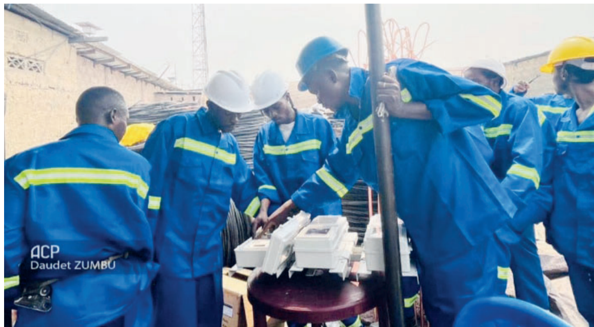
Les techniciens de la Snél plaçant des compteurs à prépaiement au camp Luka/DF
