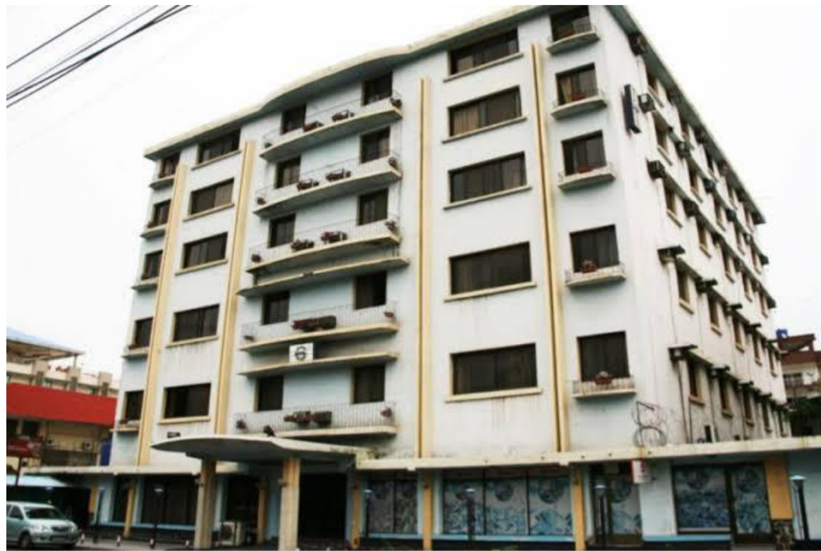
Immeuble Ave Maria
