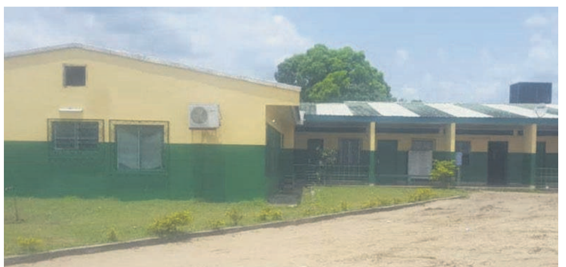
La façade du centre hospitalier réhabilité DR
