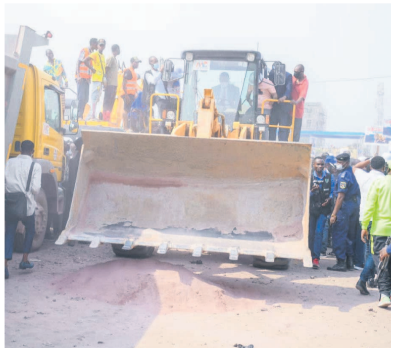
Le gouverneur Ngobila, sur une pelle chargeuse, lançant les travaux
