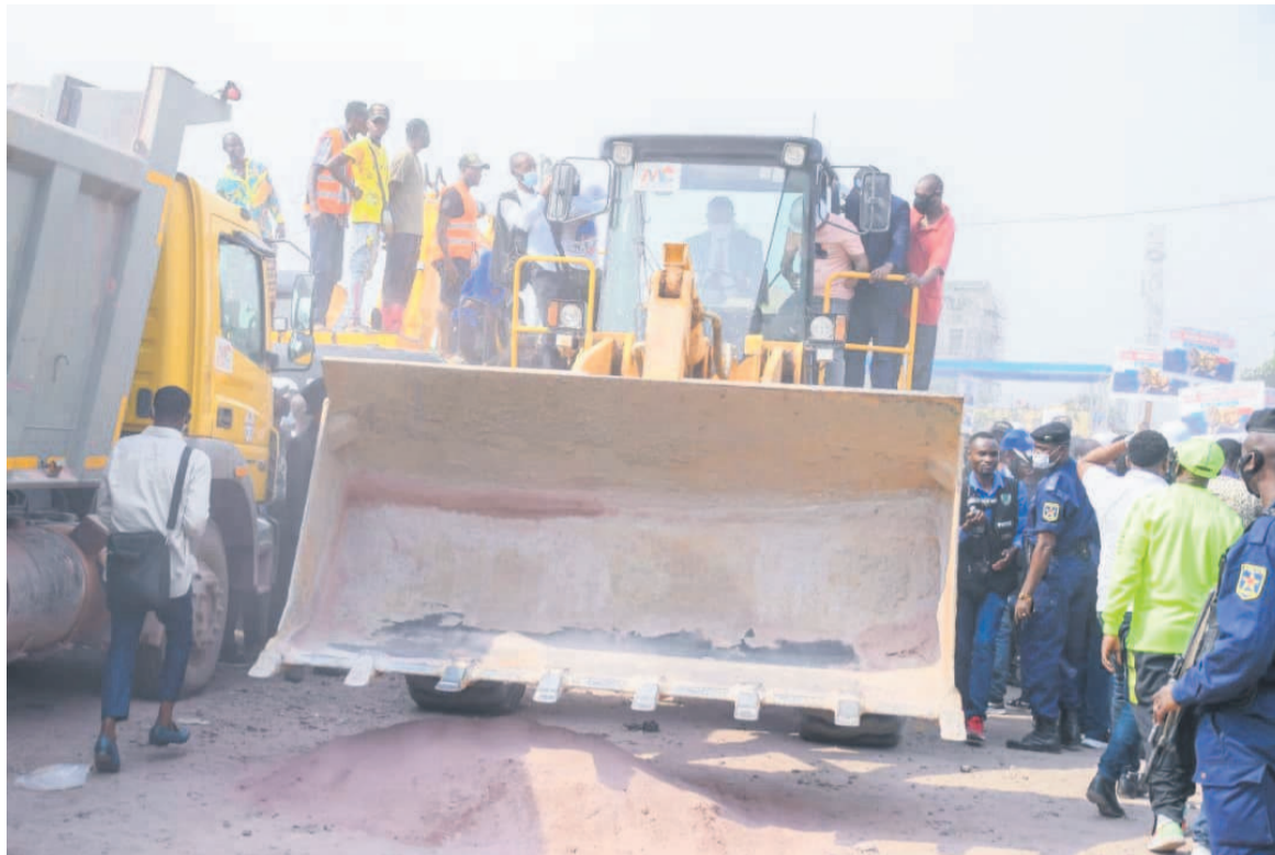
Le gouverneur Ngobila, sur une pelle chargeuse, lançant les travaux
