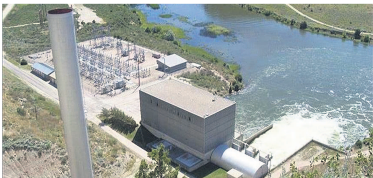
Le barrage hydroélectrique d'Inga
