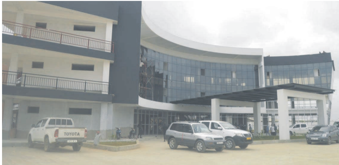
Façade principale du lycée interdépartemental de Vindoulou/Adiac
