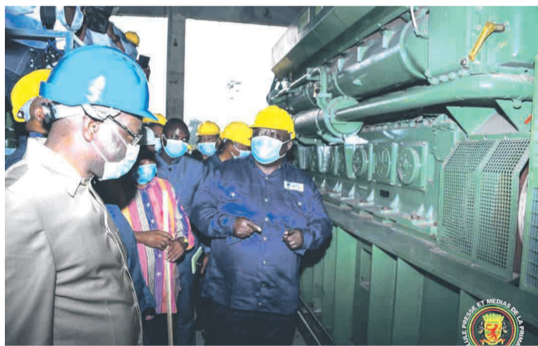
Le Premier ministre visitant le chantier DR
