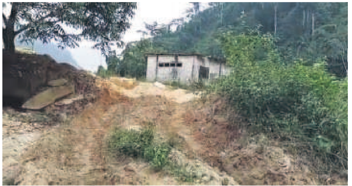
Une partie de stockage du matériel de construction du barrage dégradée
