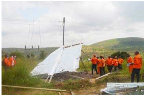
Démolition des habitations anarchiquement érigées
