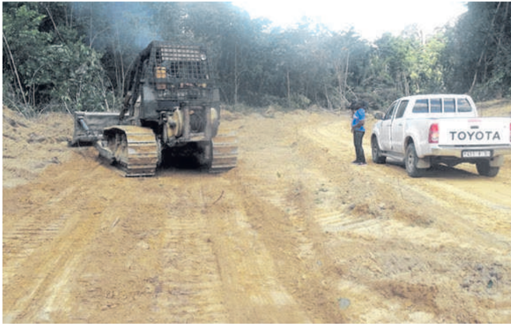
Les travaux d'ouverture à Kakamoéka/Adiac
