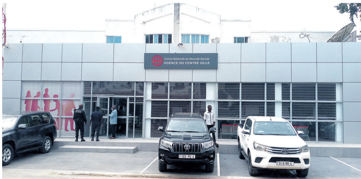
La façade principale
