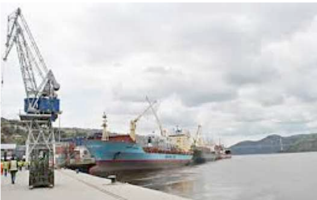
Une vue du port de l'ex-Onatra à Matadi. DR
