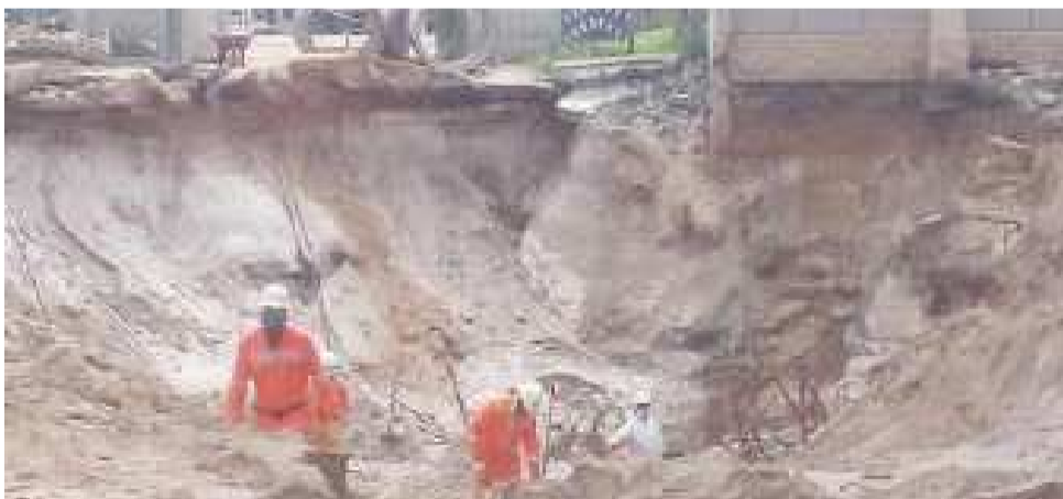
Une vue des travauxDR
