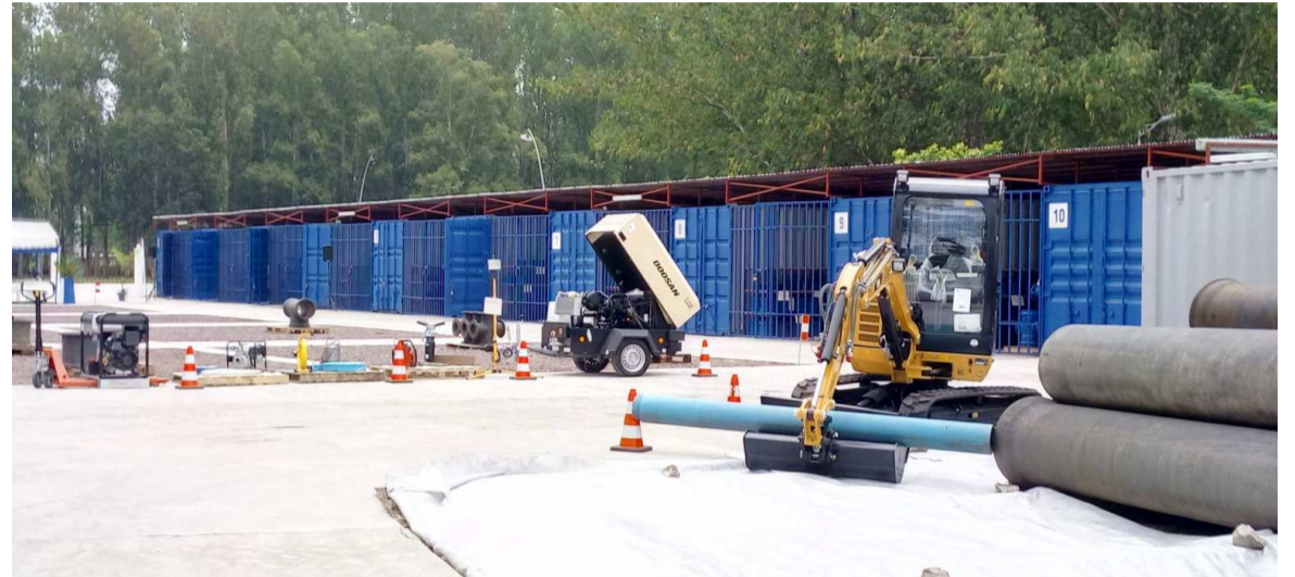
Quelques engins de travaux et du matériel d'exploitation
