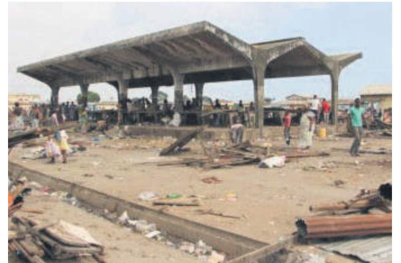
Le marché Tié-Tié Massola après sa démolition/crédit photo Adiac
