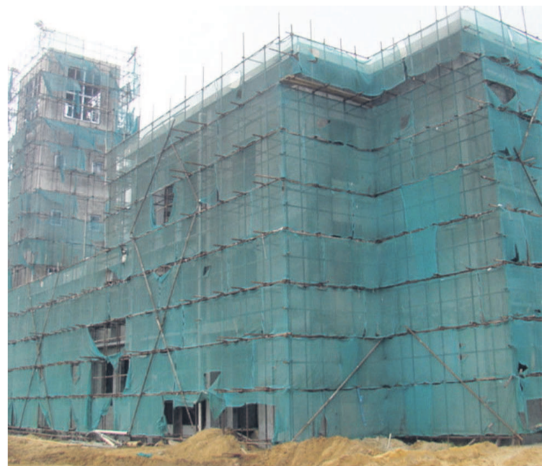
Le chantier du nouveau siège du Parlement à Brazzaville(archive)Adiac
